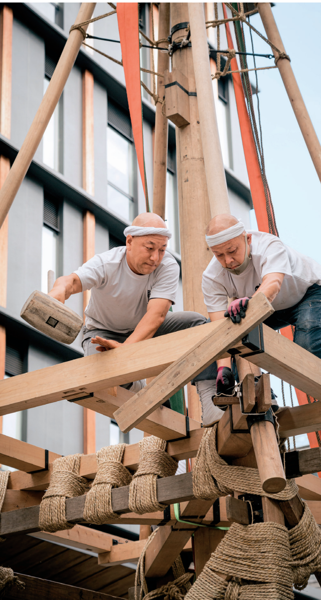
能見さんが参加する鶏鉦での「鉦建て」の様子。縄だけを使った「縄がらみ」という伝統的技法で10トン近くある鉦を組み立て、二十数名の職人たちが3日間かけて完成させる。
