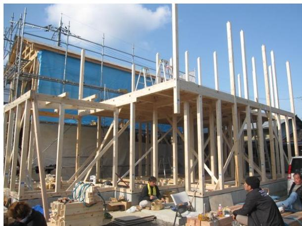
伝統工法と違い壁で耐力を造る為使用する柱、梁の大きさが小さく組み方も単純に出来る。
