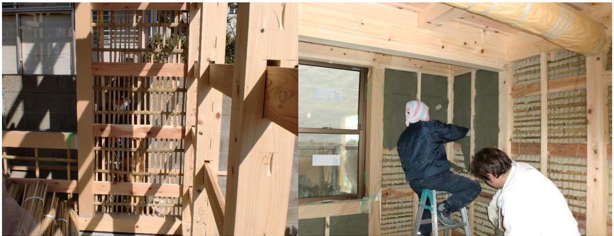
伝統工法で荒壁（土）を付ける前の<sup>たけこまい</sup>竹木舞（壁下地）と荒壁を付ける様子
