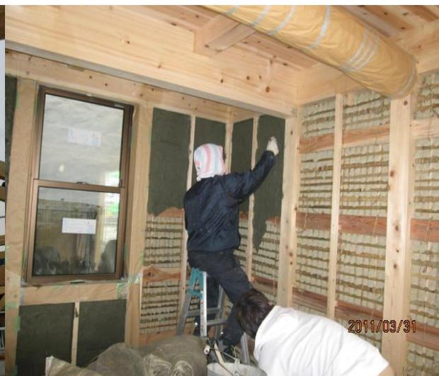
竹下地に荒壁（土）を付けている様子
